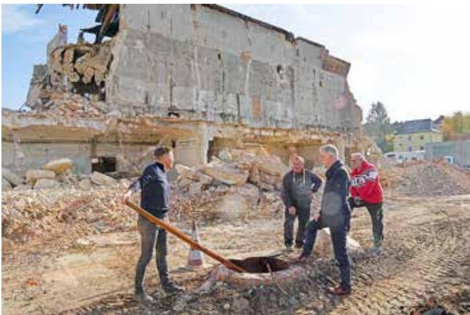
Auf der Fläche gibt es an mehreren Stellen Funde von Altölreservoirs. Diese müssen aufwändig entsorgt und die kontaminierten Bereiche saniert werden. Fotos: Stadt Freital
