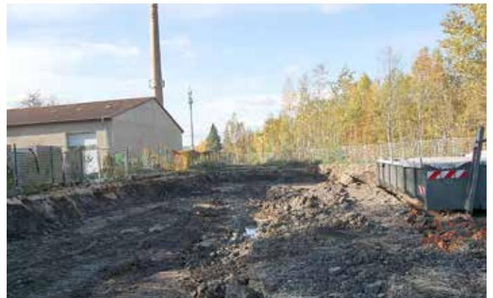
Die Sanierungsarbeiten im Bau Feld Nord im Herbst 2022. Die Gebäude sind abgerissen. Die kontaminierte Erde wird ausgebaut.
