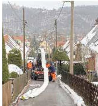
Strasse Zur Schicht, Dezember 2022: Inlinereinbau, Aushärtung mittels Dampf
