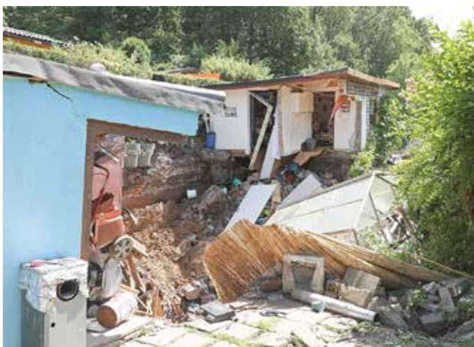
In der Kleingartensparte „Rotkopf Görg“ sackt durch frühere Bergbauarbeiten eine Fläche von zehn mal zehn Metern mehrere Meter tief ab.
