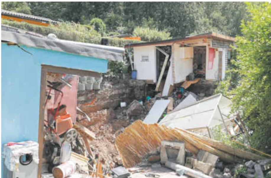
In der Kleingartensparte Rotkopf-Görg sind nach einem Tagesbruch mehrere Parzellen mit darauf befindlichen Kleingartenhäuschen massiv beeinträchtigt. Zwei Bungalows wurden unmittelbar zerstört, zwei weitere mussten in den Folgetagen aufgrund massiver Schäden abgerissen werden.
